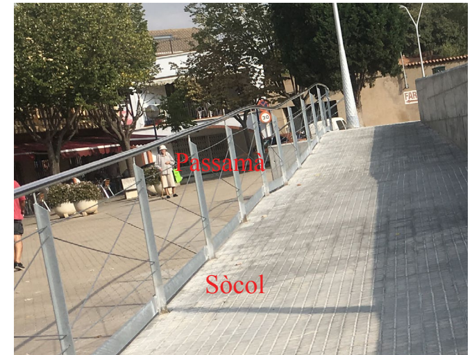
Rampa de la plaça del Vallés: És un model de rampa perquè té passamans i un sòcol.
