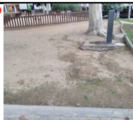
És una font situada al costat dels jocs infantils. Per arribar a la font i als jocs infantil el camí és inaccessible perquè hi ha un esglaó a la rampa i un esglaó molt important per accedir als jocs i a la font.
