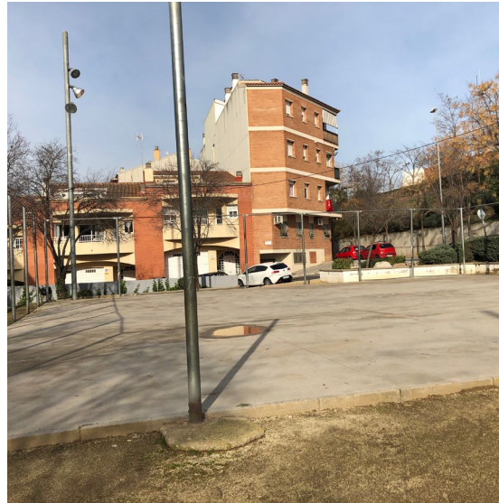
Pista de bàsquet Permetre el pas pel costat de la pista de basquet. Construcció de vorada de formigó: 30 € x 1m = 30 €
